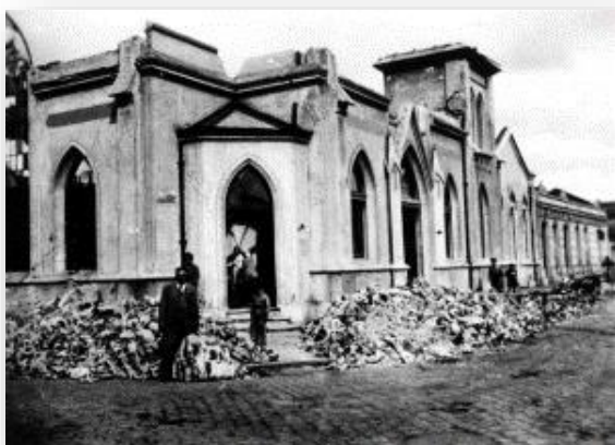
Iglesia después del terremoto de 1939
